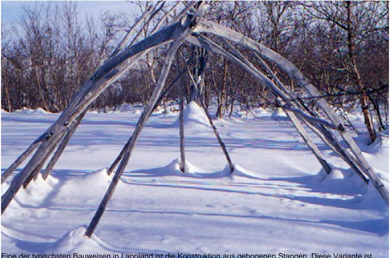
Eine der typischsten Bauweisen in Lappland ist die Konstruktion aus gebogenen Stangen. Diese Variante ist schnell und einfach aufzubauen. Vier gebogene und speziell gearbeitete Stangen werden mittels einer Firststange und zwei weiteren Querstangen miteinander zum Grundgerüst verbunden. Wie bei der Stangenkota werden nun weitere Stangen gegen diesen Rahmen gelehnt und das ganze mit einer Zelthaut aus Fell oder Wolle bedeckt.
