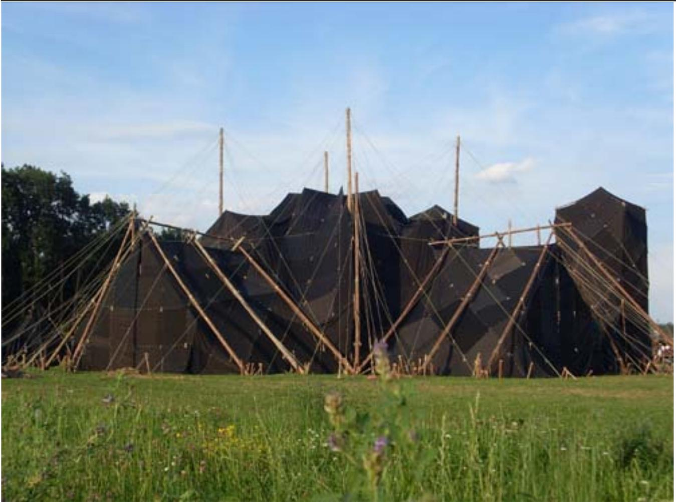
Für den Bau braucht es 500 Viereckzeltbahnen, 100 Kohten- und Ovaljurtenbahnen. Die Zentralkuppel misst in der Höhe 9 Meter, die Kirchenschiffe 6 Meter und die beiden mächtigen Türme sogar 11 Meter.
