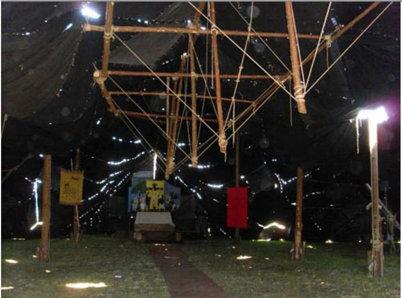
Das Dach selbst ist frei tragend und wird durch eine Luftstützenkonstruktion gestützt. In der Kuppel trägt eine einzelne Luftstütze die Spitze der Konstruktion.
