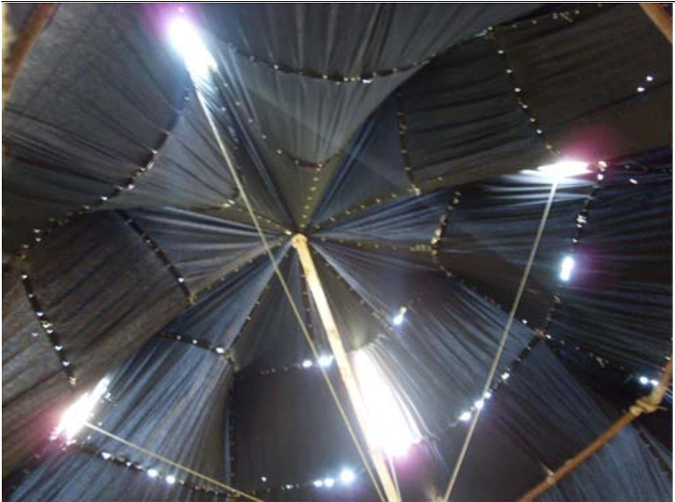
Zur Abspannung der Masten werden 3,8 Kilometer Kunsthafseile mit einem Durchmesser von 10 mm verwendet. Für die Bünde in den Türmen, bei den Masten und zur Verbindung der Planen braucht es weitere 10 Kilometer Bindschnur.
