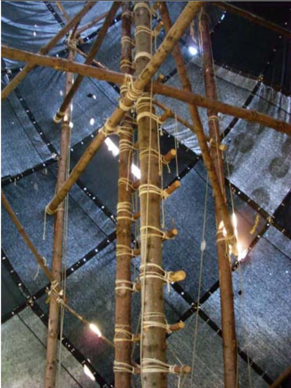
Uns gefällt die Einfachheit, mit der dieses große Zelt aufgestellt wurde. Keine Jurtenschrauben, keine Stahlpflocke, sondern Schnur und Holz halten das Konstrukt. Und auch bei kräftigeren Winden wabert zwar etwas die Hülle aus Stoff, aber die Kathedrale als solche steht sicher verankert da. Fast wie für die Ewigkeit...
