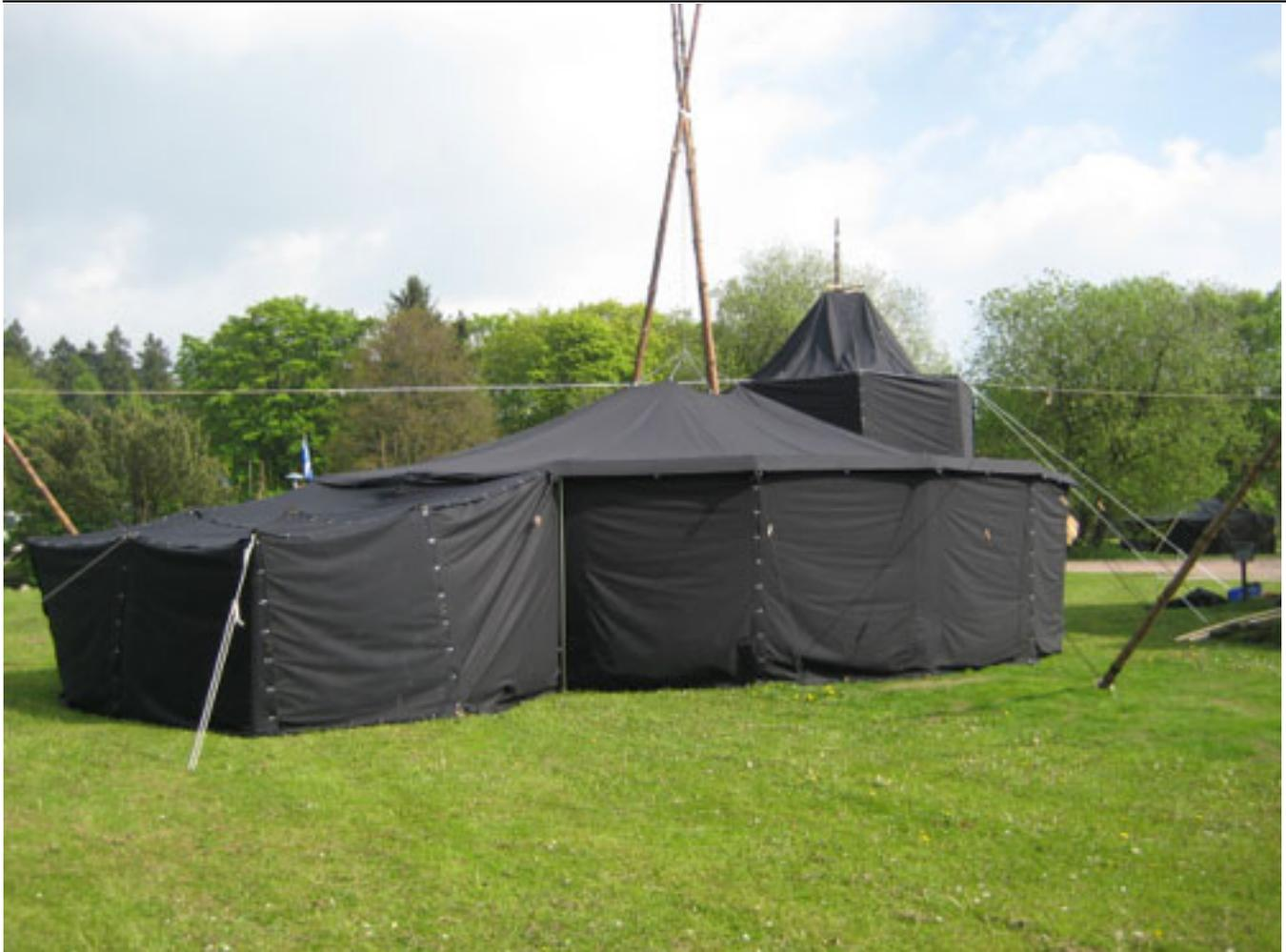
Und damit die Kapelle auch nicht gar so klein wird, erhält sie eine Erweiterung aus mehreren Seitenplanen. Hier gilt es jedoch darauf zu achten, dass bei Regen keine Wassersäcke entstehen und die Planen in der richtigen Reihenfolge übereinander liegen.
