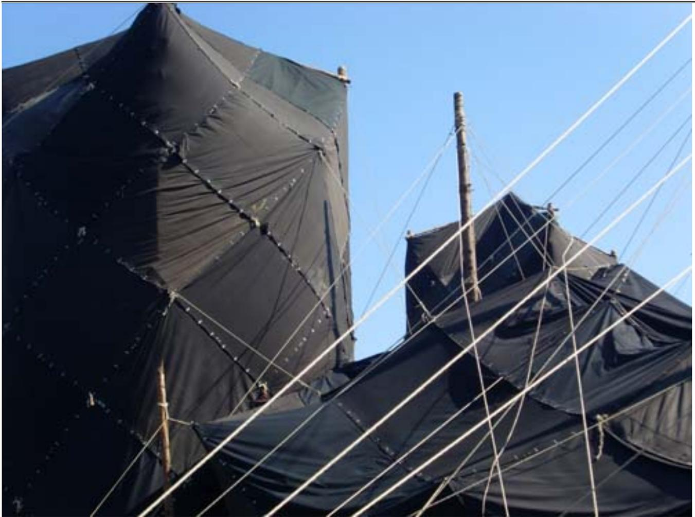
Die gesamte Kathedrale ist an acht Masten mit bis zu 12 Meter Höhe, den beiden Türmen und je drei Scheren über den Kreuzschiffen und dem Chor aufgehängt. Die Masten stehen wie in ihren steineren Schwestern, zwischen dem Hauptschiff und den Seitenschiffen.
